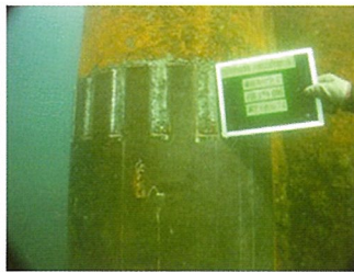
【調査により貫通孔が確認された鋼管杭】 【鋼板溶接工法にて補修を行った鋼管杭】
