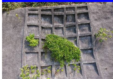
急傾斜対策施設の点検例
