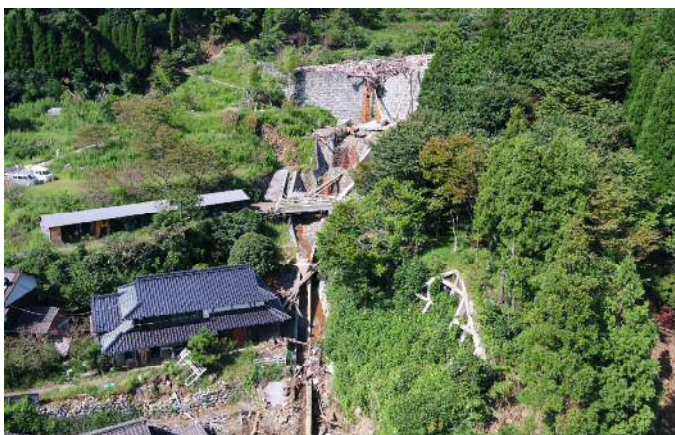
九州北部豪雨被災写真の撮影_朝倉市
