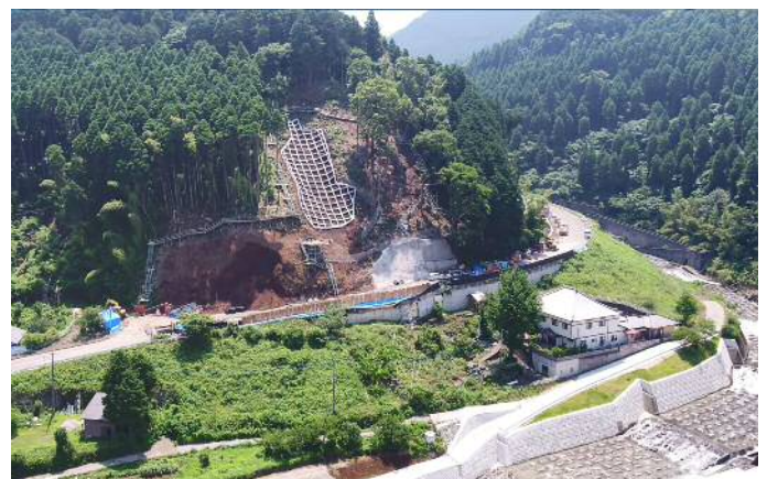
熊本地震被災写真の撮影_益城町
