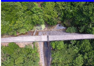
砂防施設の点検例
