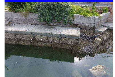
港湾施設の点検例
