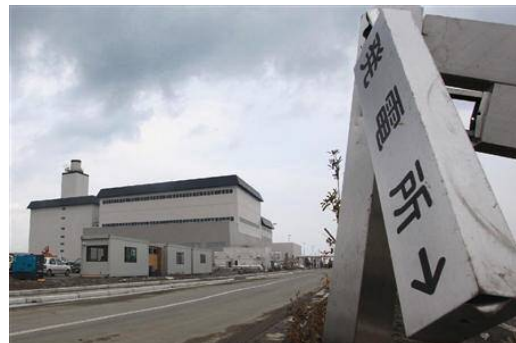
看板が傾いた新仙台火力発電所 3月31日、宮城県仙台市
