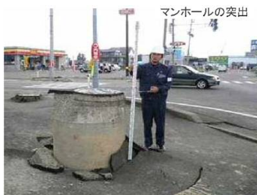
新潟県中越地震における下水道施設の被害の状況
